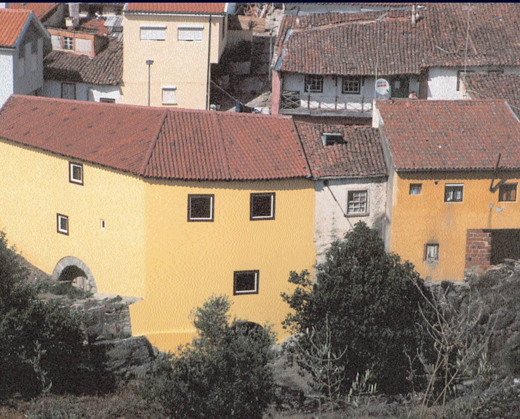
Instalações do Centro das Sedas de Bragança, na margem esquerda do rio Fervença, outrora uma tinturaria.
